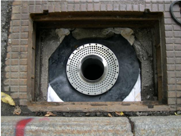
Bild 7.4 Absorbo monterad i en dagvattenbrunn.
