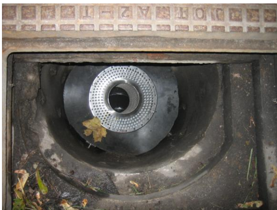
Bild 5.11 Absorbo monterad i brunn.
