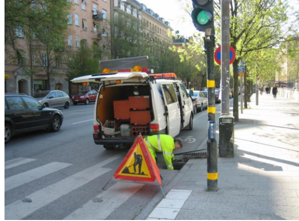
Bild 9.8 Filtren plockas upp på Sveavägen.
