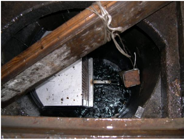
Bild 7.6 SorbClean installerad i en brunn stöttad med en plank.
