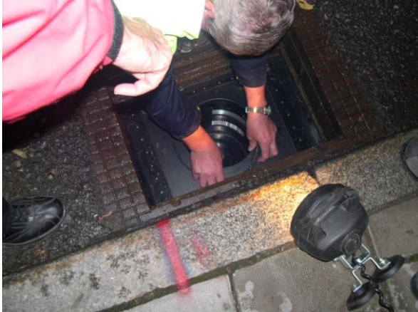
Bild 9.9 a och b Innolet monteras i brunn.
