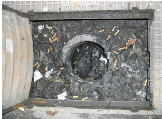
Bild 5.2 Innolet monterad i brunn och efter ett antal månaders drift.
