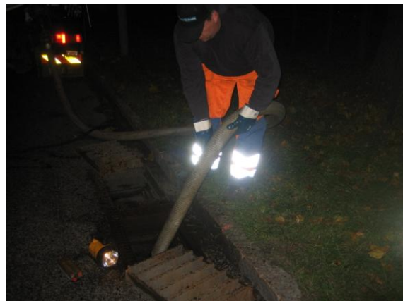
Bild 9.6 Renspolning av dagvattenbrunnarna skedde nattetid.
