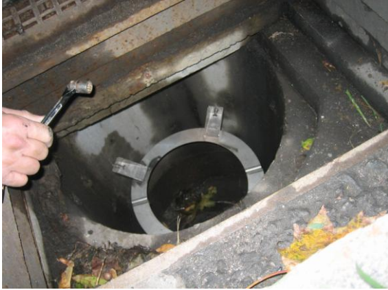
Bild 9.14 a och b Svårigheter i att fästa Absorbo i brunnen förekom.
