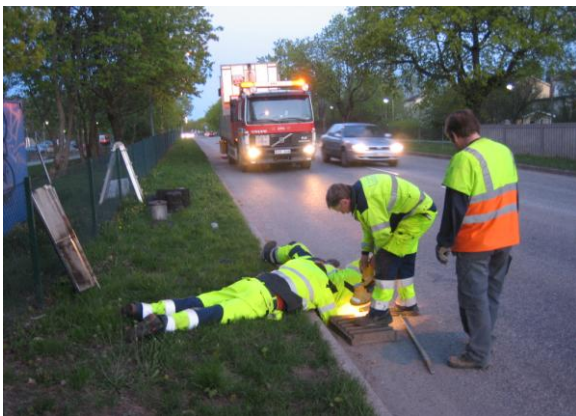
Bild 9.15 a och b Flera personer behövdes för att lossa Absorbo från brunnen.
