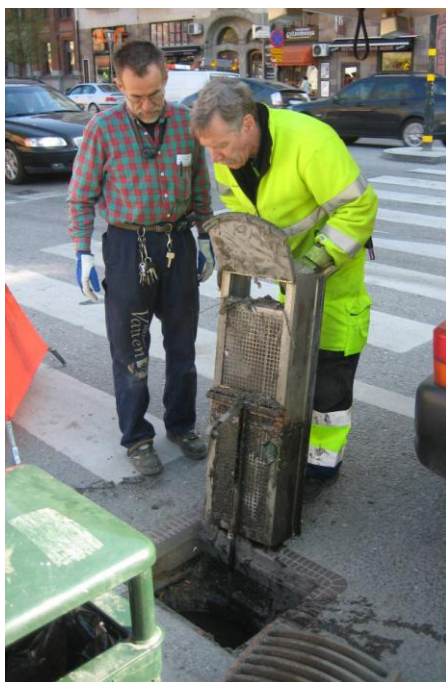
Bild 5.7. SorbClean lyfts upp ur brunnen efter undersökningens slut.
